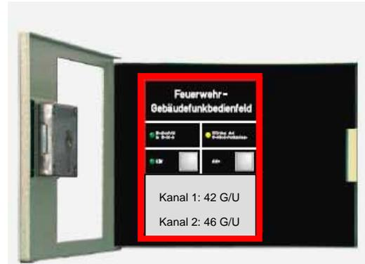
Bild 1: Feuerwehr-Gebäudefunkbedienfeld nach DIN 14 663
