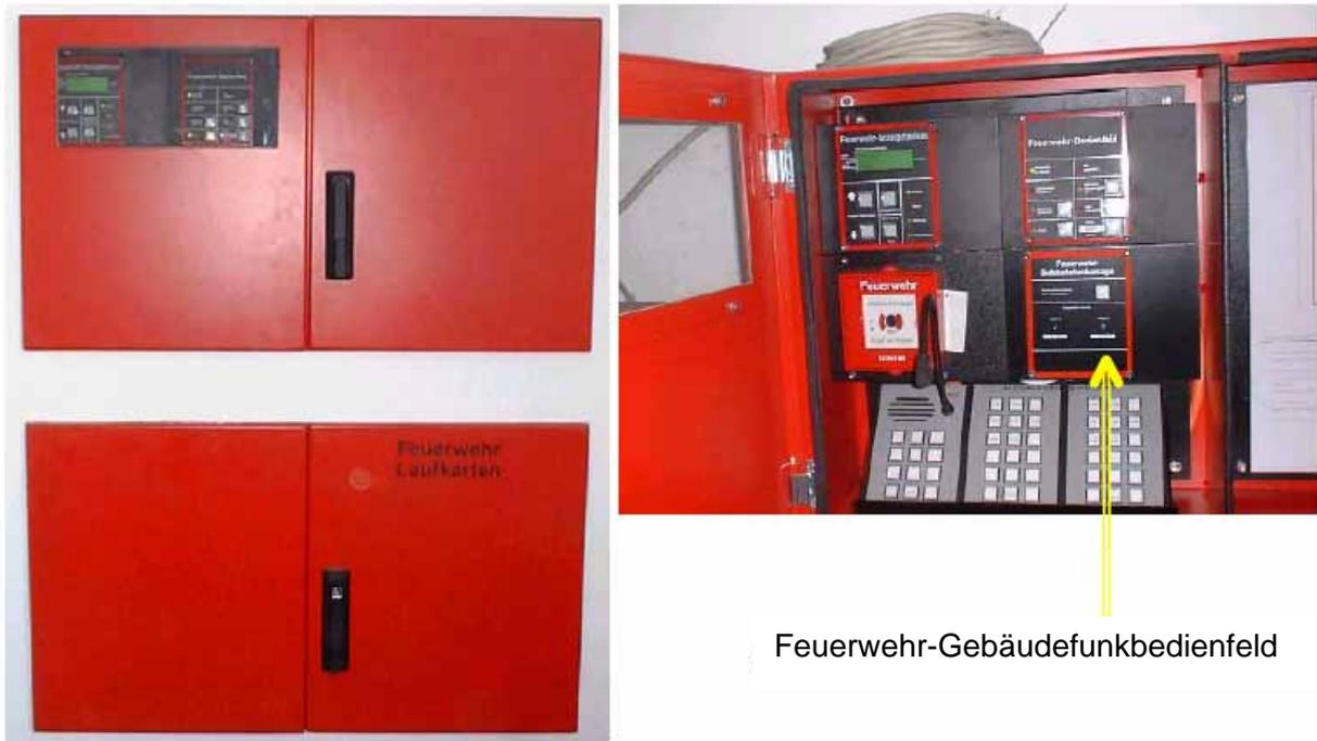
**Bild 3:** Beispiel zur Integration eines Feuerwehr-Gebädefunkbedienfeldes in ein Feuerwehr-Informationszentrum (FIZ)
