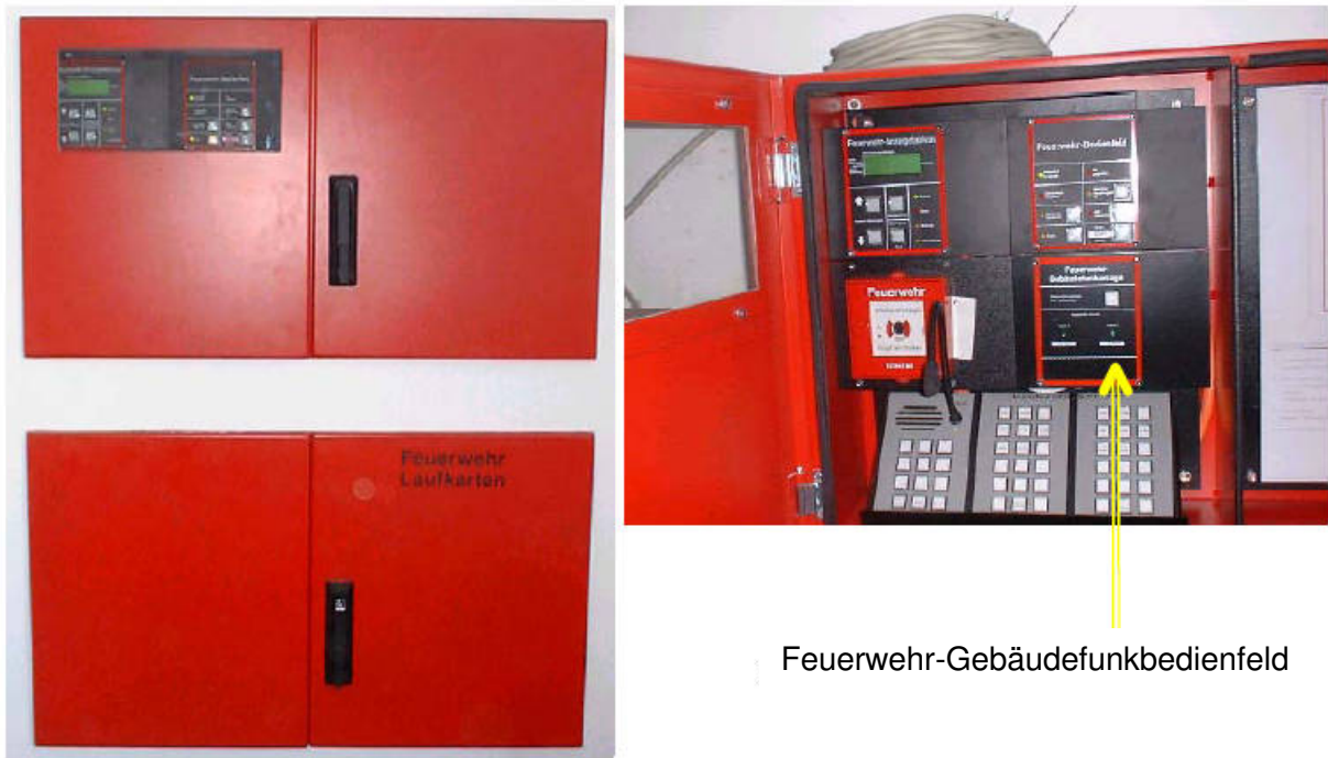
Bild 3: Beispiel zur Integration eines Feuerwehr-Gebäudefunkbedienfeldes in ein Feuerwehr-Informationszentrum (FIZ)
